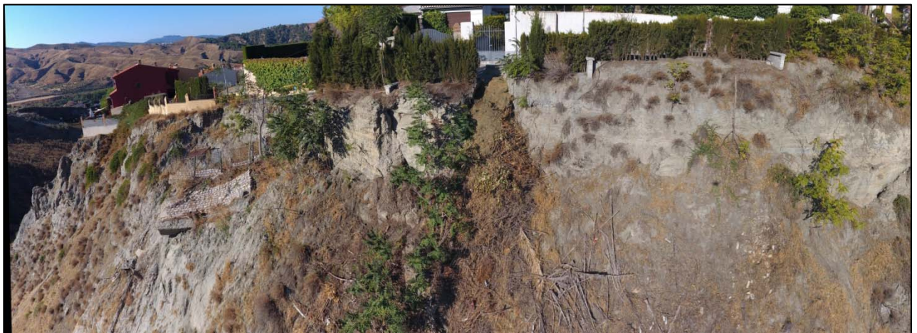
Calle Nardos. Fotografía aérea de la zona del deslizamiento. (Fuente: Oriol Ingeniería Civil)
