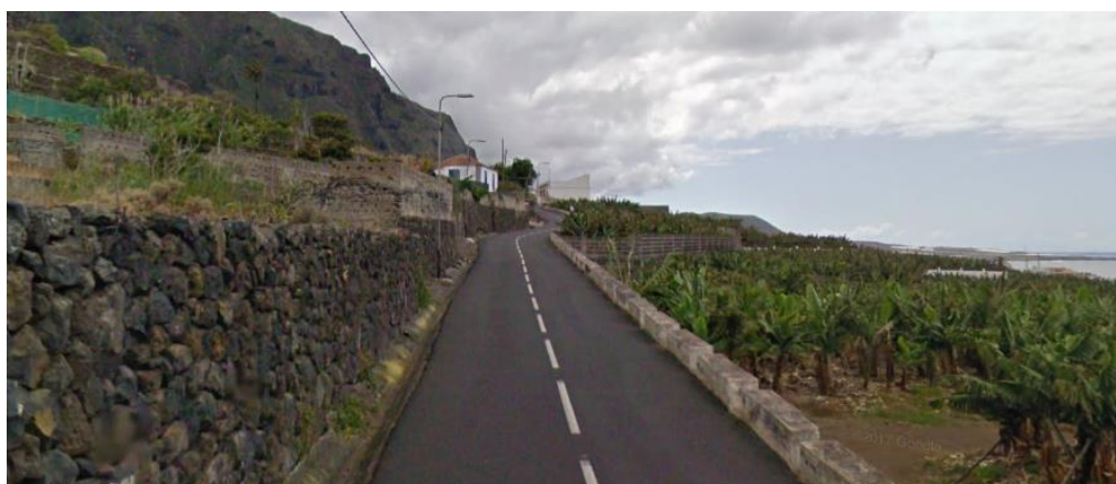
FOTO 2: sección tipo de la carretera en suelo agrícola.
