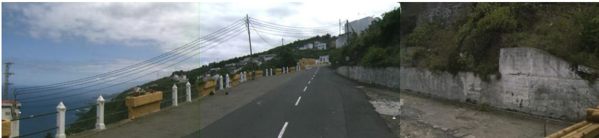
FOTO 10: Acceso al cementerio del Tanque P.K. 6+610
