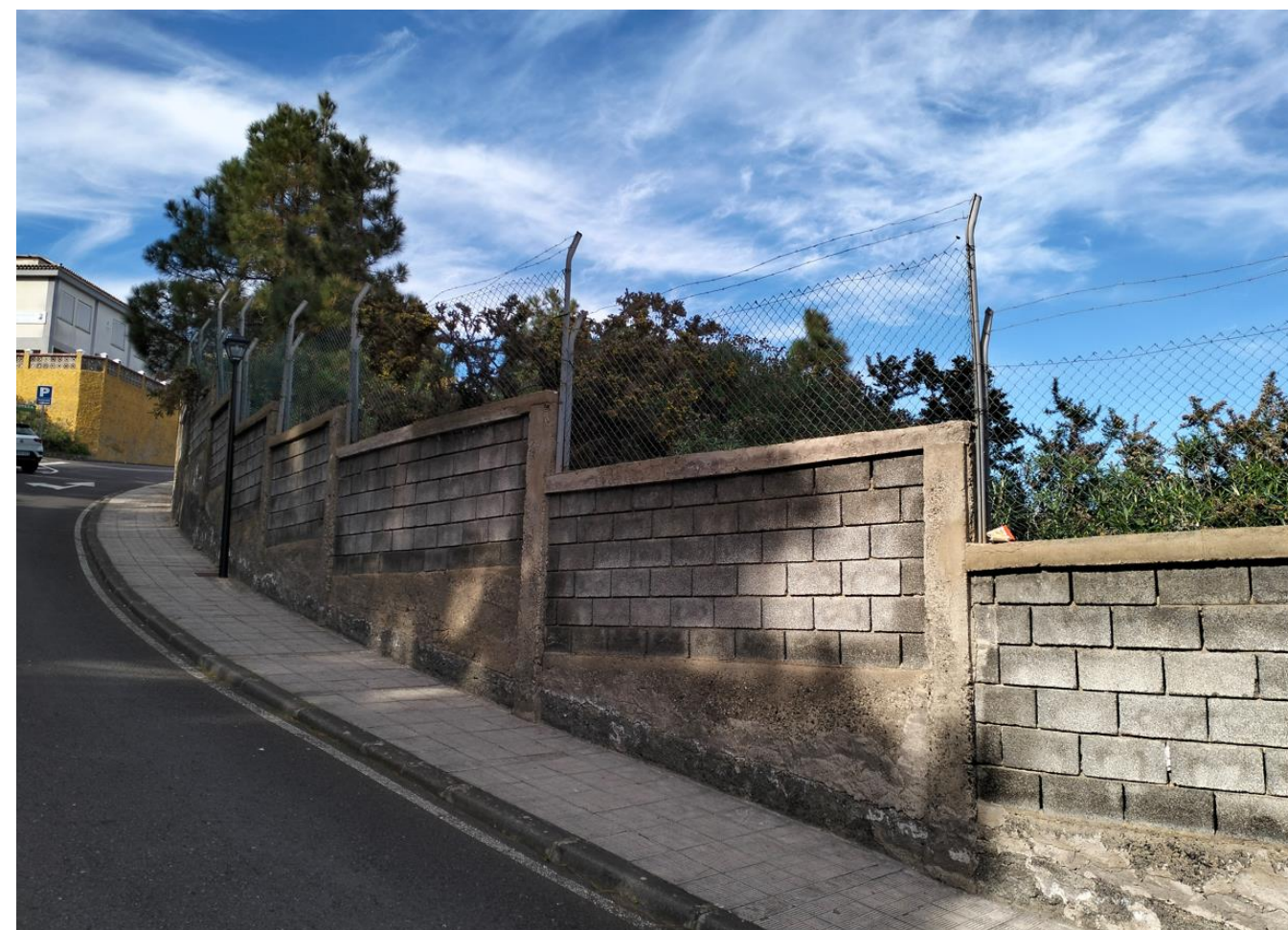
Tramo existente del cerramiento, pendiente de la vía y módulos escalonados
