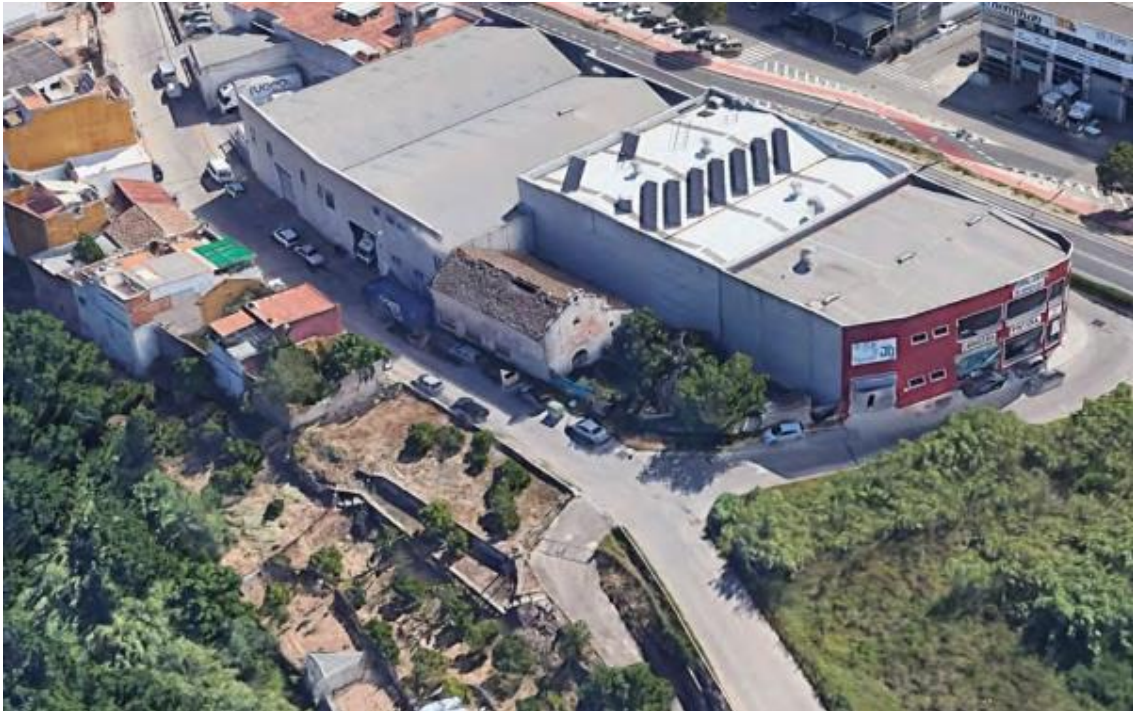
Localización e imagen aérea de la ermita previa al incendio
