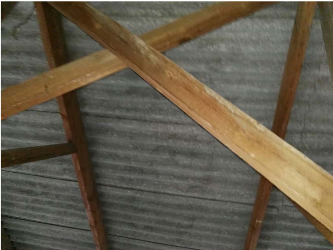
Detalle de arriostamiento transversal de las cerchas.
