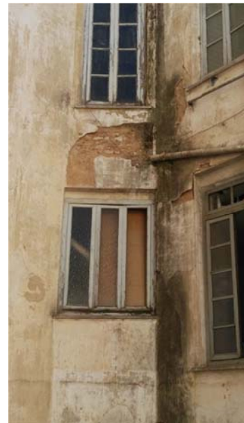
Detalle muro fachada posterior
