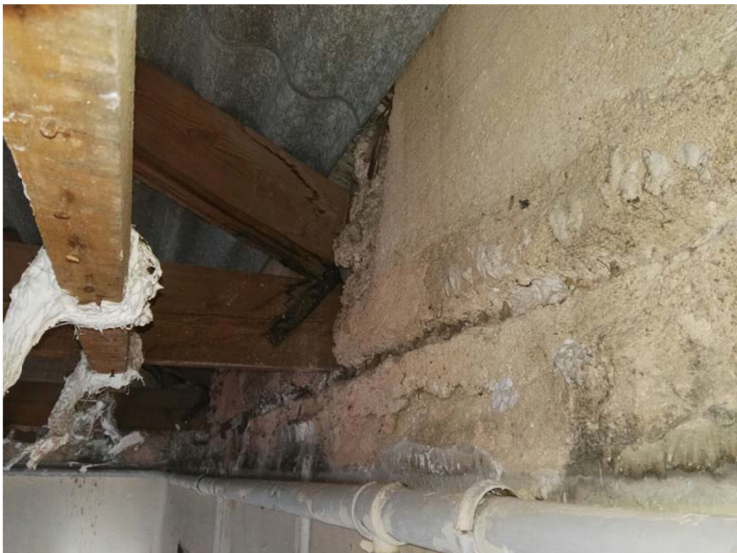
Vista de entrega de la cercha al muro.
