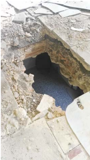
Detalle cata 1 techo pl.baja
