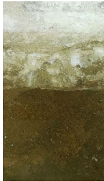
Detalle cemento muro
