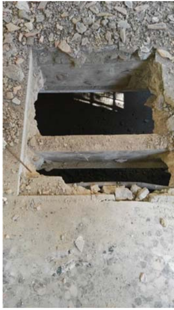
Detalle cata 1 forjado madera
