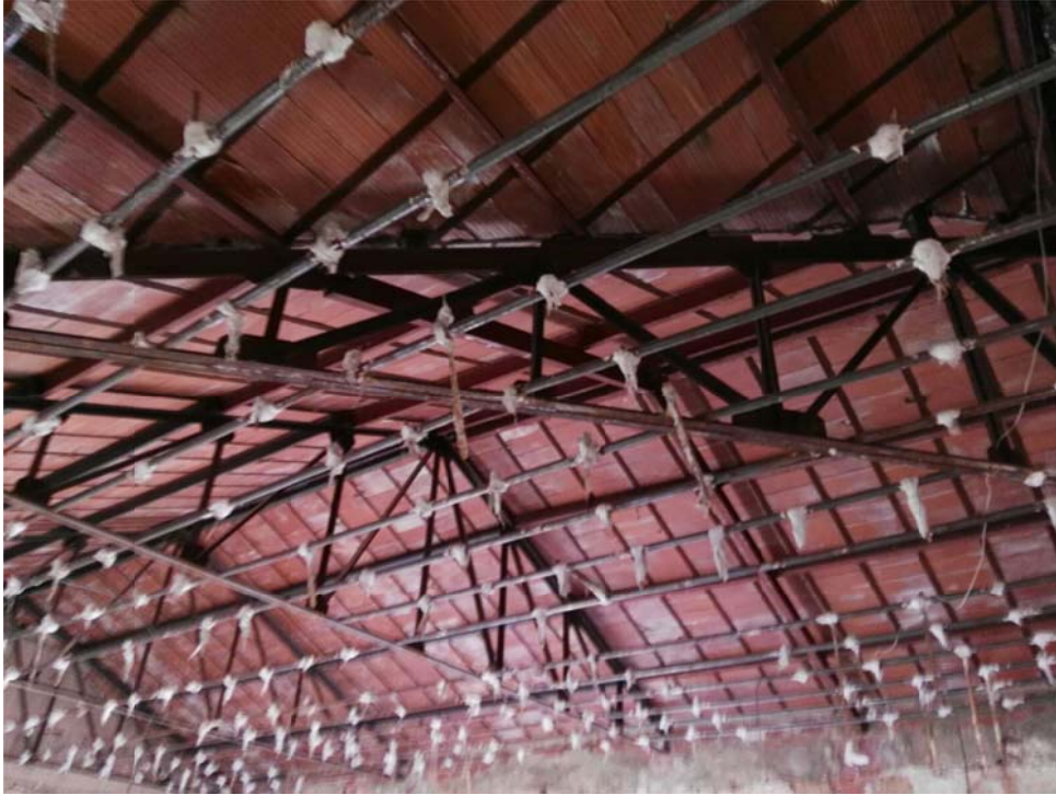
Vistas generales de la cercha metálica.
