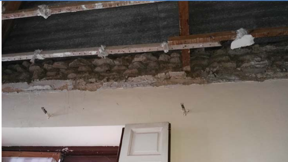
Detalle coronación de muros
