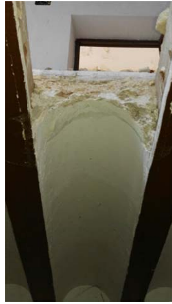
Detalle composición forjado
