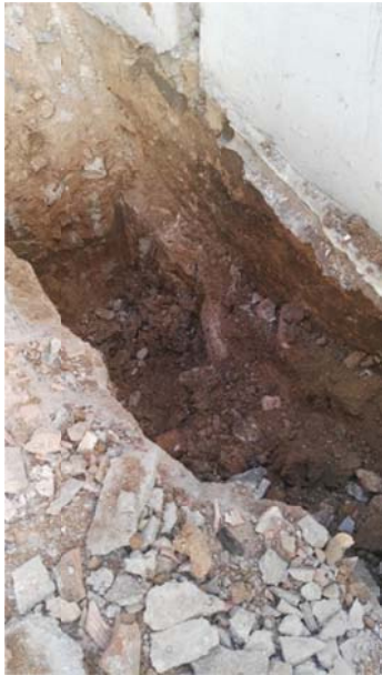
Detalle cemento muro
