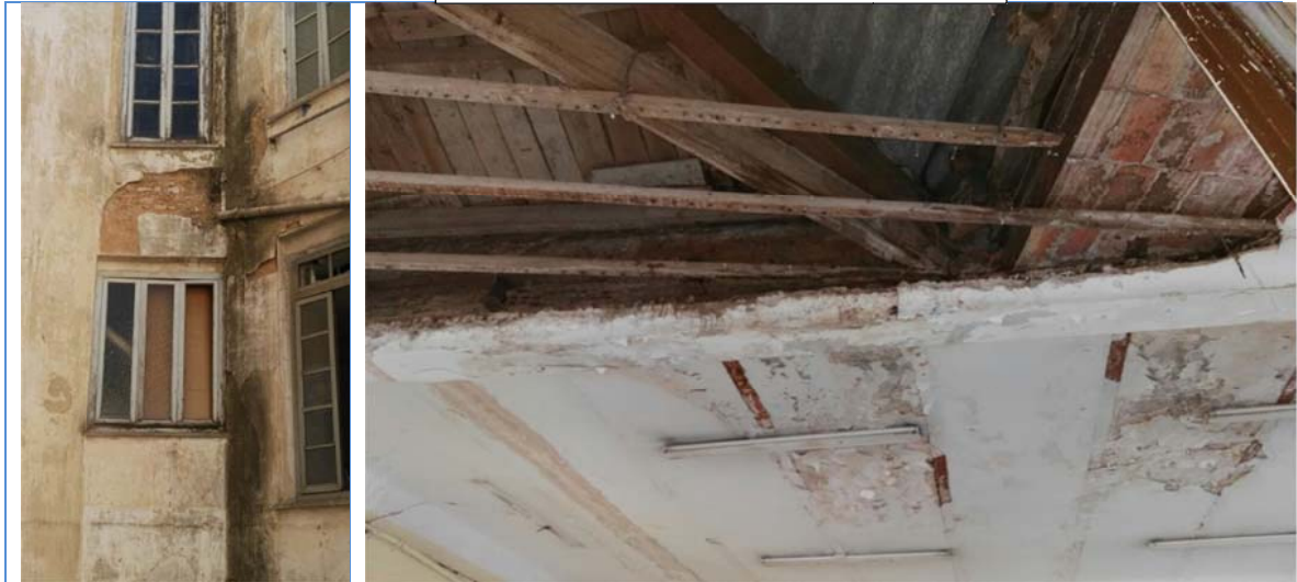
Zona de goteras filtraciones y goteras
