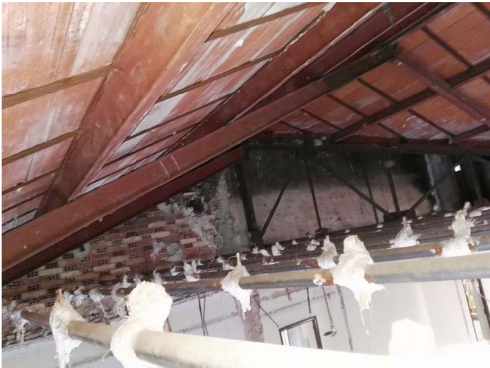
Vista general de la cercha metálica, zona unión ambos cuerpos.
