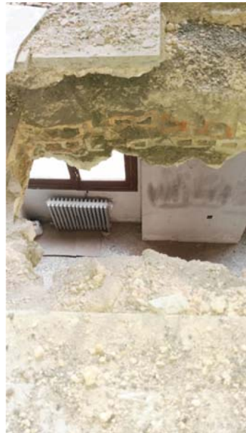
Cata 1 en techo pl.baja
