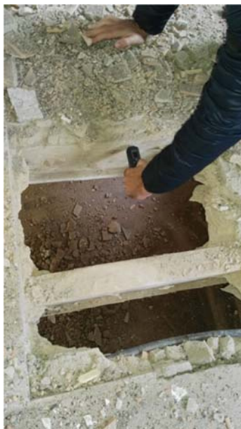
Detalle medición humedad in situ
