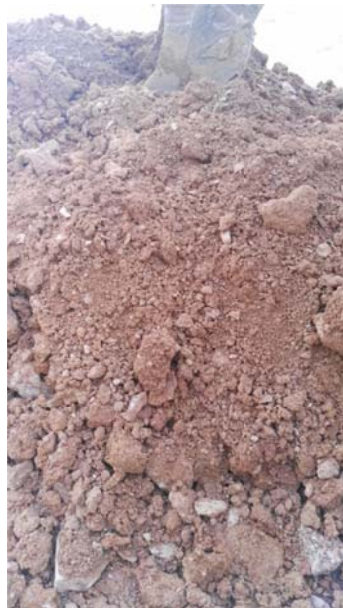
Terreno apoyo cimentación
