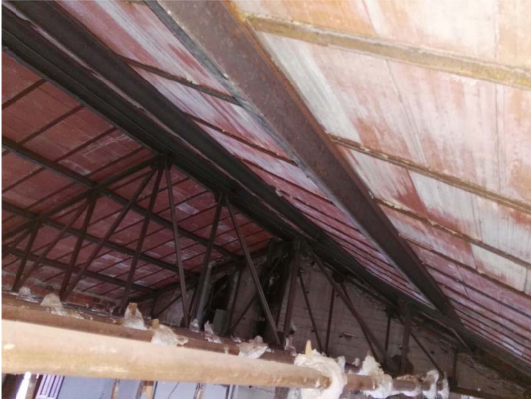
Vista general. Zona muro hastial medianero.
