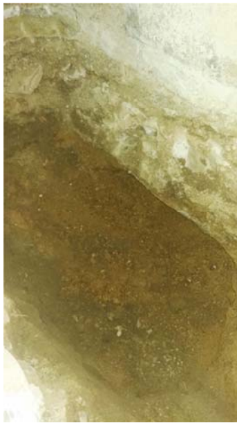
Detalle cemento muro
