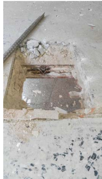
Detalle cata 2 techo pl. baja
