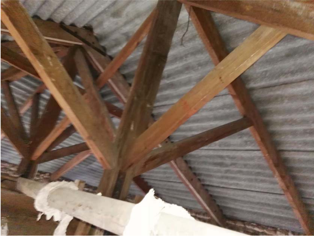
Vista general de la cercha.
