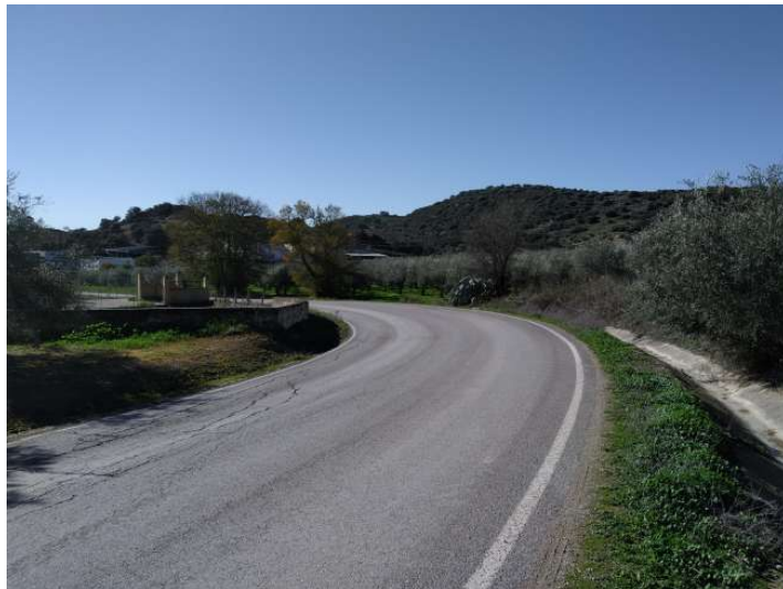
Vista general estado actual ctra.
