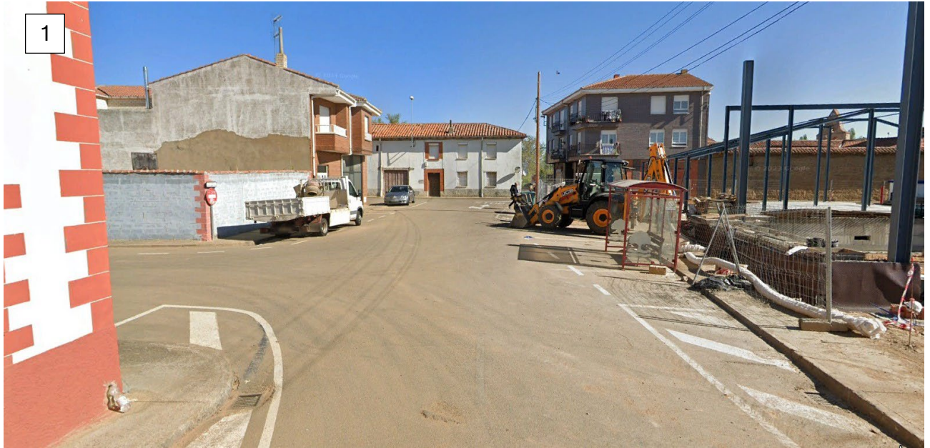
Calle Vega. - Vista tramo desde Consistorio a Santiago apóstol.
