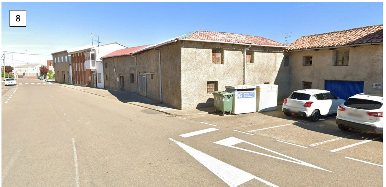
Calle Consistorio. - Vista de zona de aparcamiento junto a ayuntamiento, intersección con avenida de la Constitución.
