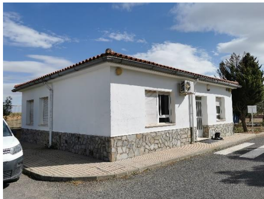
Ilustración 21 Edificio de control
