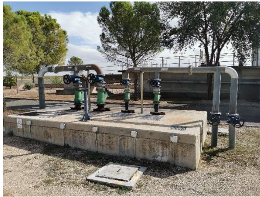
Ilustración 23 Recirculación y purga
