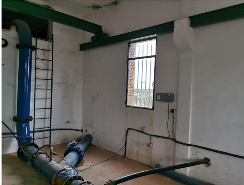
Ilustración 4 Estado general interior edificio I
