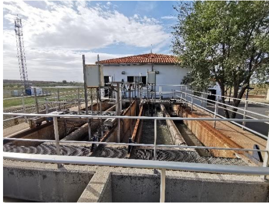
Ilustración 17 Canales desarenadores-desengrasadores
