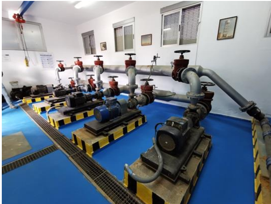
Ilustración 9 Interior edificio bombeo
