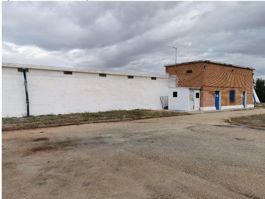
Ilustración 6 Depósito agua tratada
