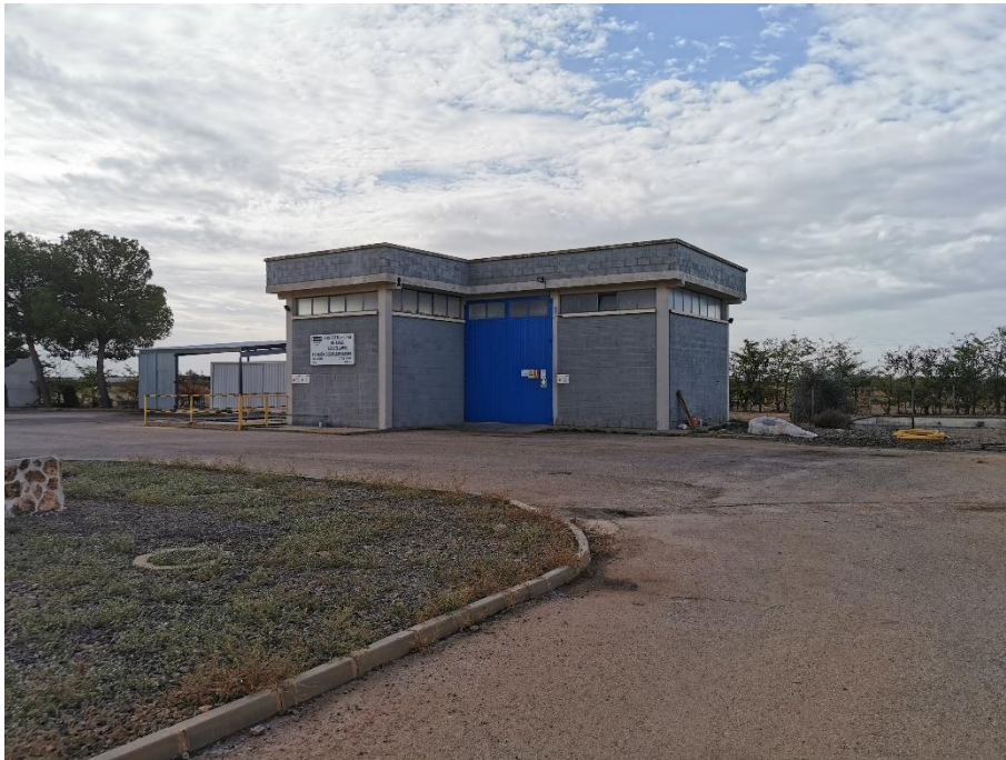
Ilustración 7 Edificio de descalcificación
