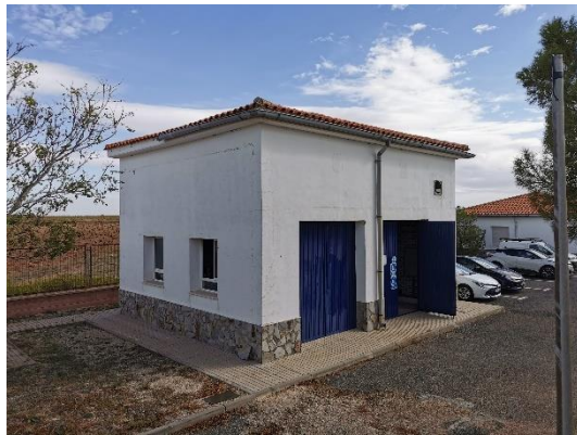
Ilustración 19 Edificio de soplantes
