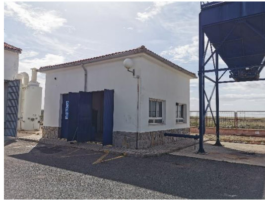
Ilustración 24 Edificio de deshidratación
