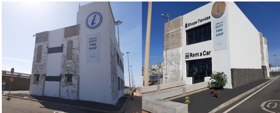
Vista de las fachadas a revestir.
