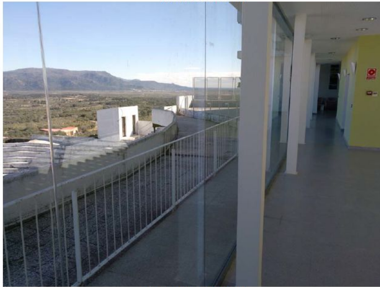
GALERIA PLANTA BAJA
