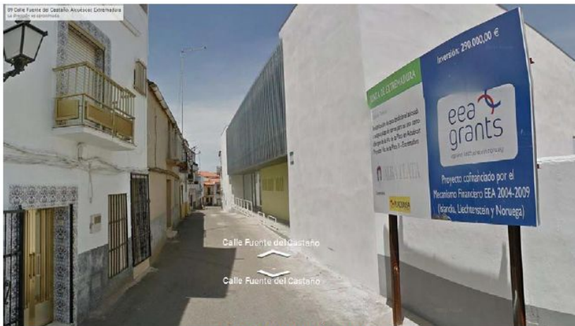
FACHADA VIA PÚBLICA
