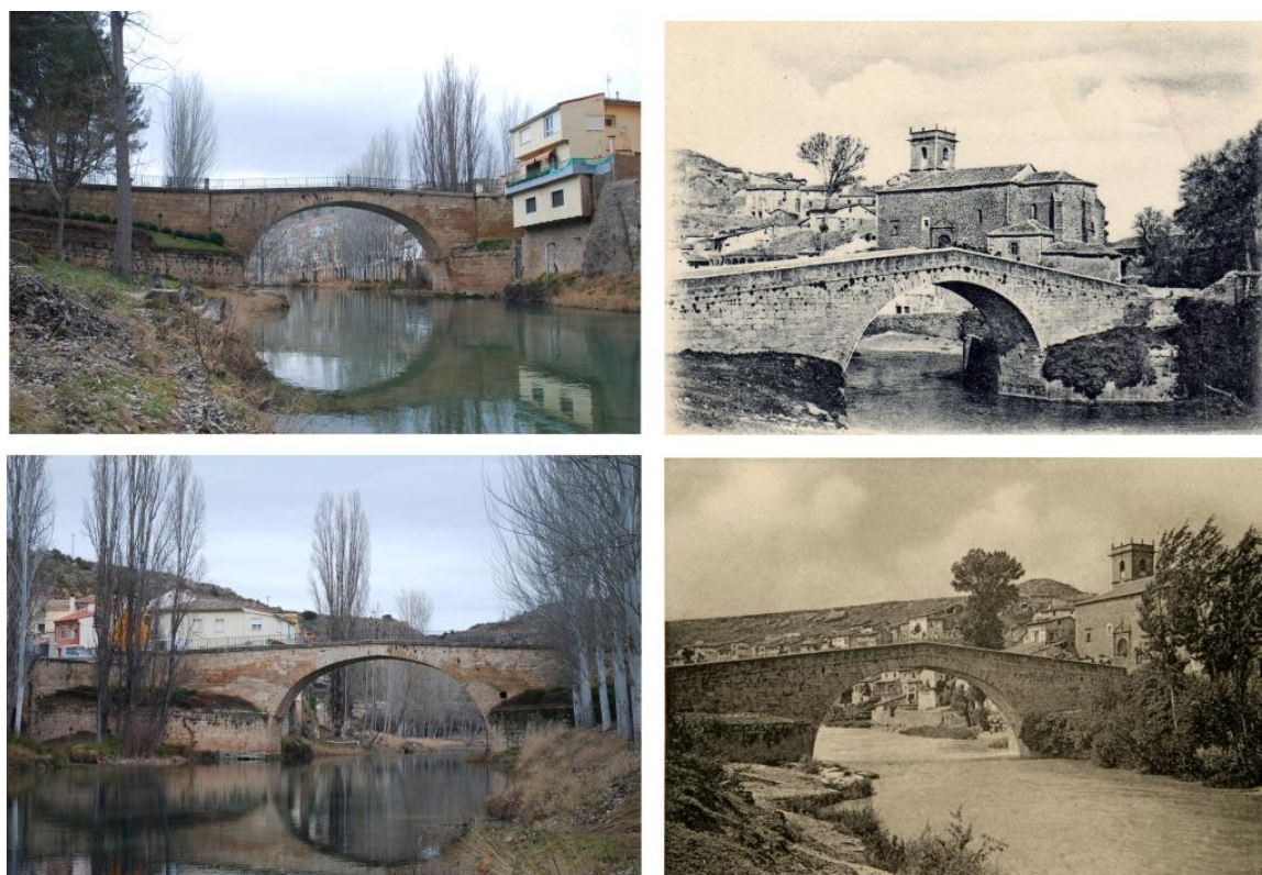
Figura 2: Detalle del puente desde aguas arriba y abajo (izquierda) y algunas instantáneas históricas (derecha). Fuente: ABN Patrimonio.
