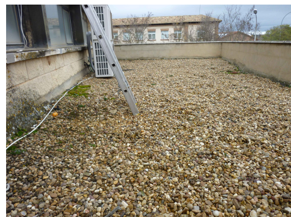
FOTOGRAFÍAS DE LA CUBIERTA
