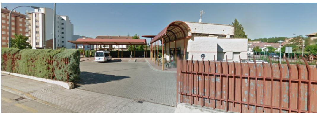
Estado anterior de la Estación de Autobuses (imágenes 2013)
