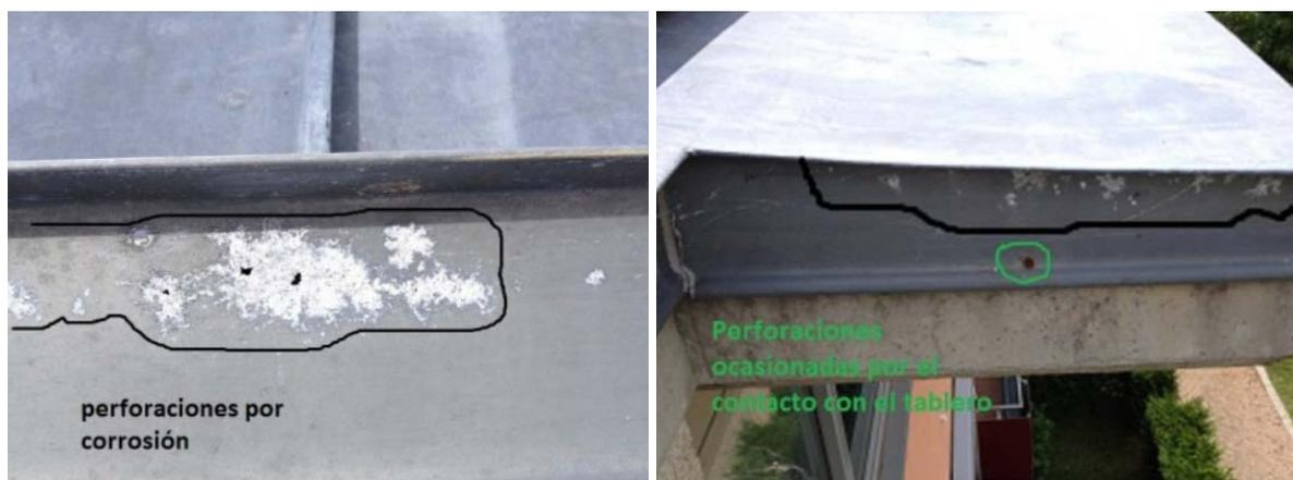
Vista de corrosión de zinc y grado de degradación al que llega
