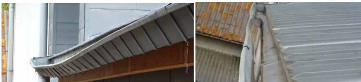
Vista del canalón deformado, el agua no desagua en la bajante.
