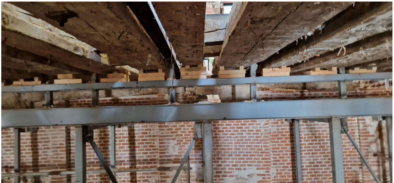
Fotografía 2. Vista de la cara inferior de las vigas.
