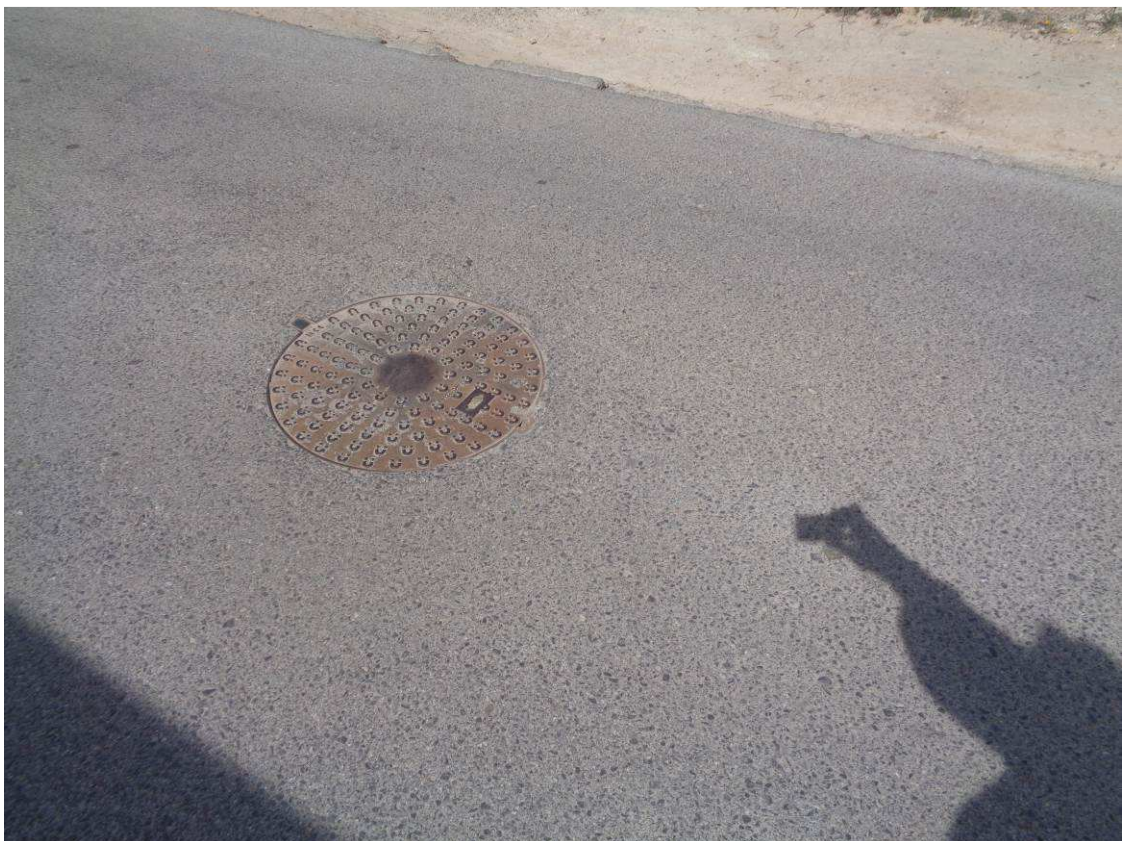
FOTOGRAFÍA 6: Vista de arqueta de saneamiento en calzada.
