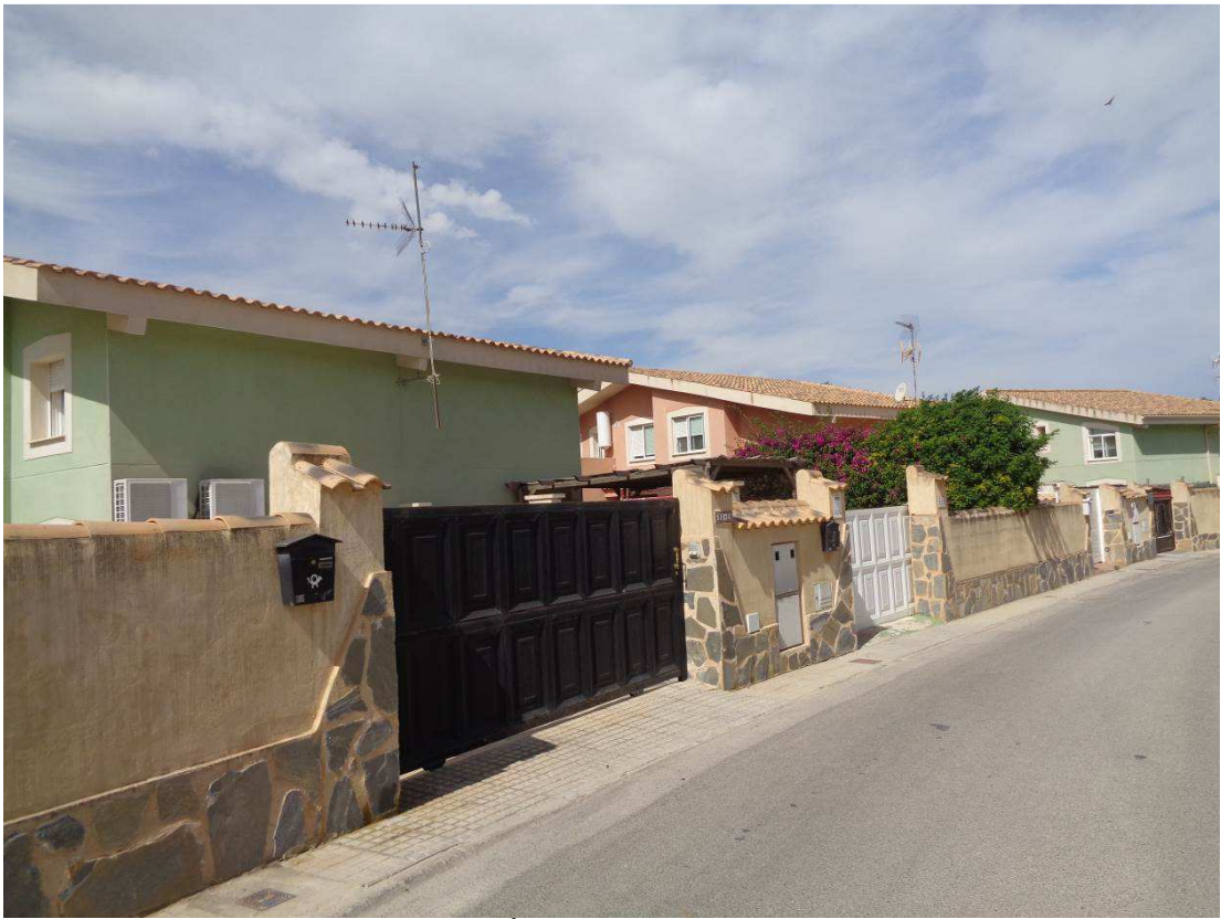
FOTOGRAFÍA 9: Vista del entorno urbano.
