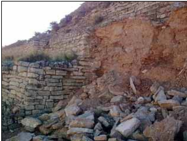
Vista del extremo izquierdo del muro, aflorando rellenos en la parte alta y lutitas Terciarias en el resto
