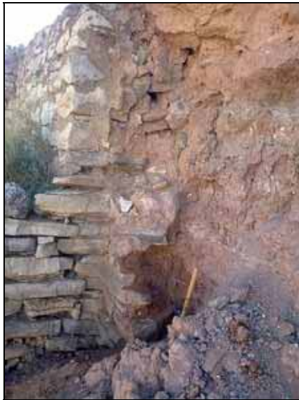
Detalle del contacto rellenos antrópicos-sustrato Terciario (lutitas), lado izquierdo
