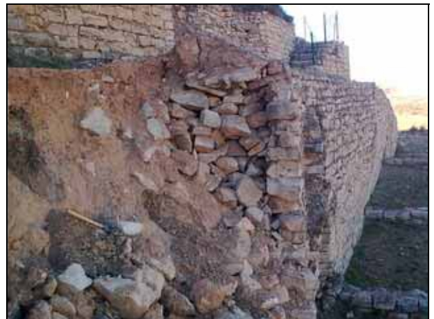
Vista del trasdós adosado al talud de rellenos antrópicos.
