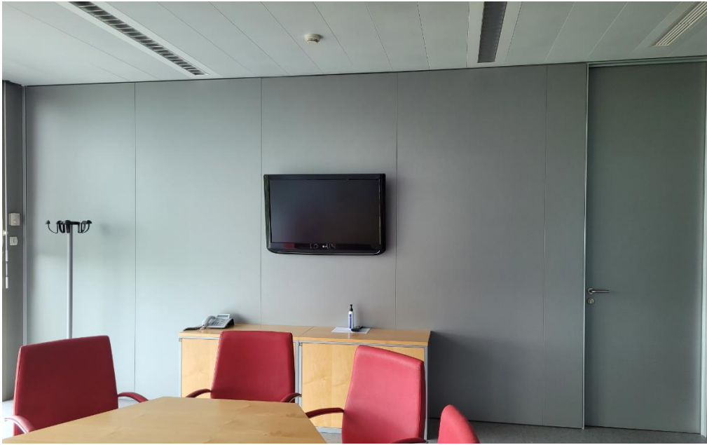
3.Mampara ciega con puerta perpendicular fachada.
