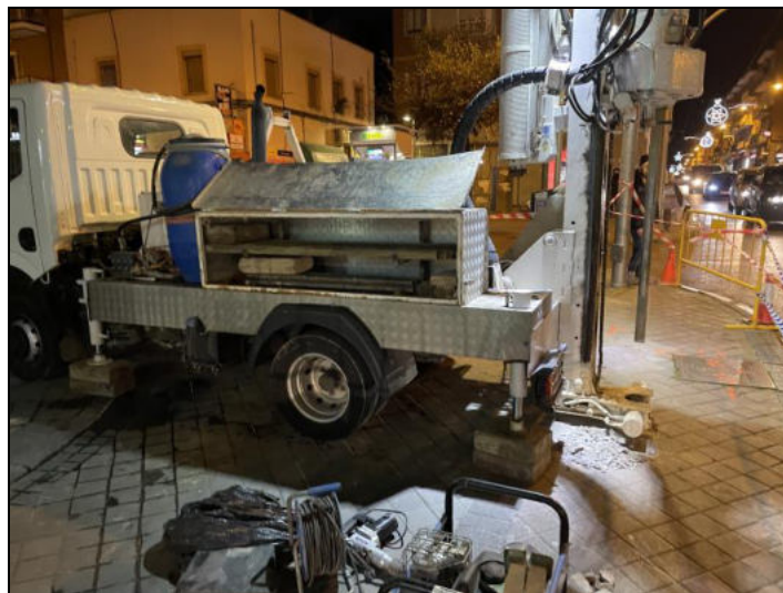
Fotografía 2: Emplazamiento del ensayo de penetración dinámica DPSH nº2 con puntaza perdida
