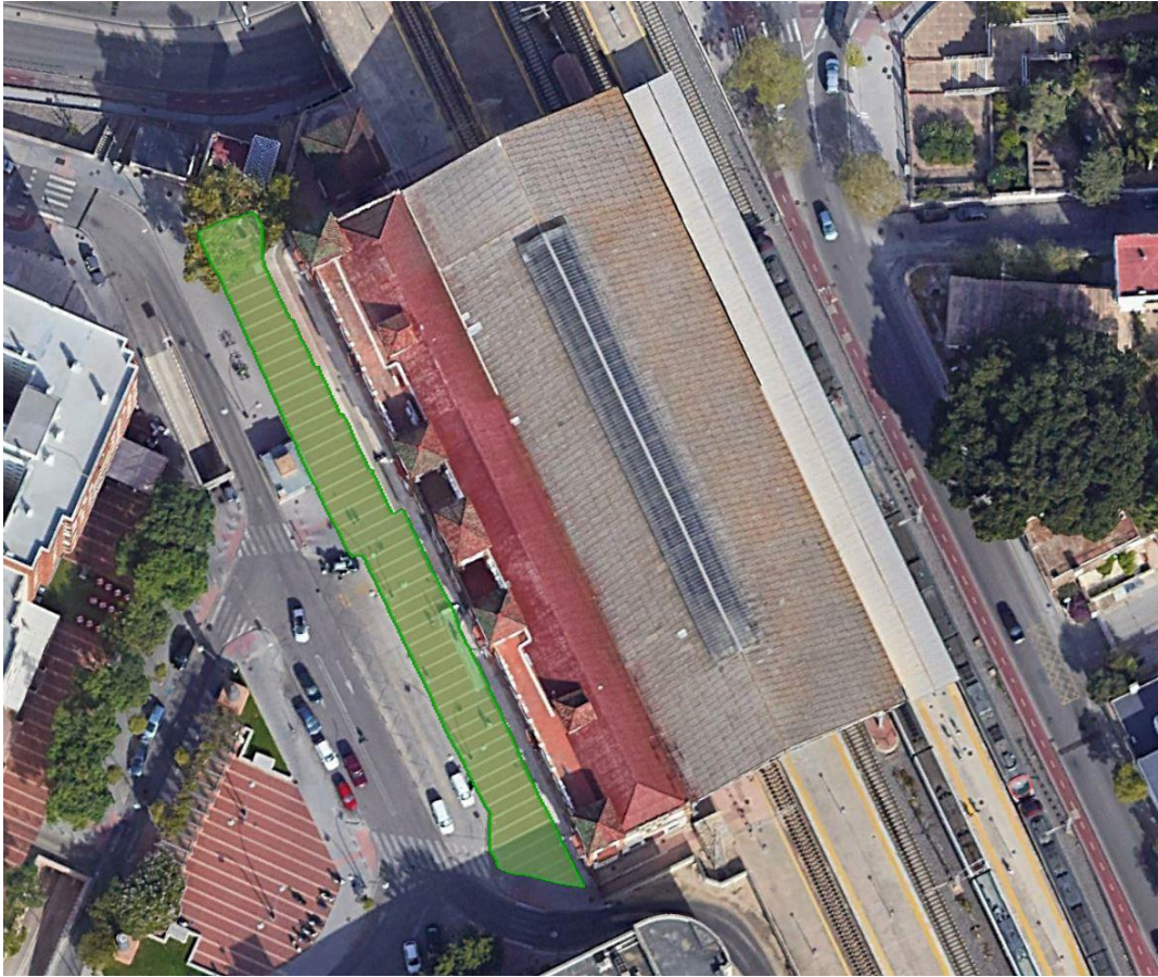
Área de actuación en la explanada de acceso a la estación.
