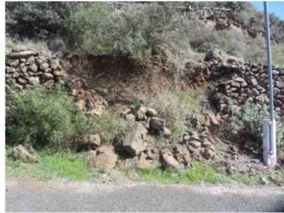
Fotos 1 y 2, Muros de contención de ladera de piedra seca en riesgo de derrumbe
