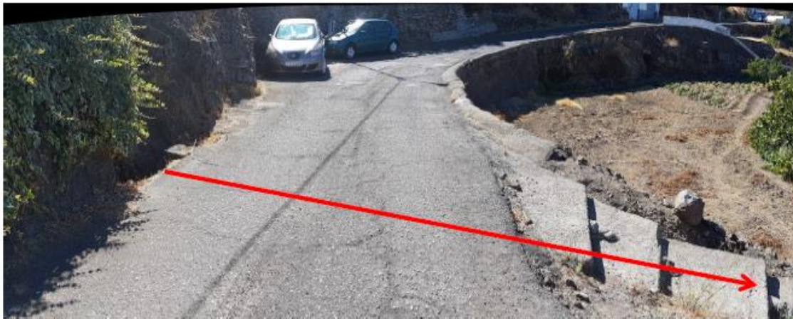
Foto 9. Obra drenaje transversal existente en p.k. 0+435
