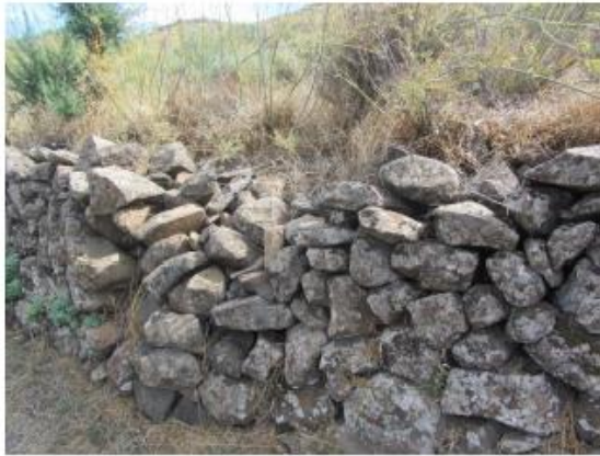
Fotos 1 y 2, Muros de contención de ladera de piedra seca en riesgo de derrumbe
