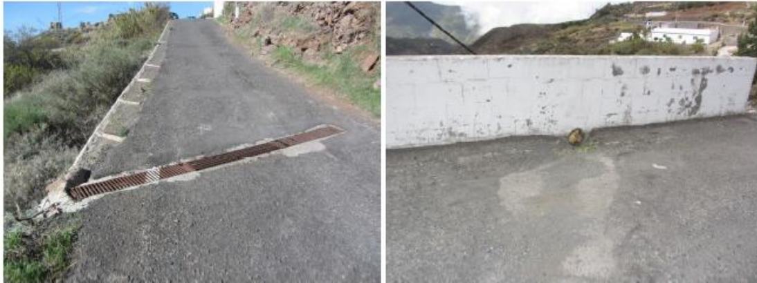
Fotos 7 y 8. Reja transversal p.k. 0+180 y desagüe en murete p.k. 0+525
