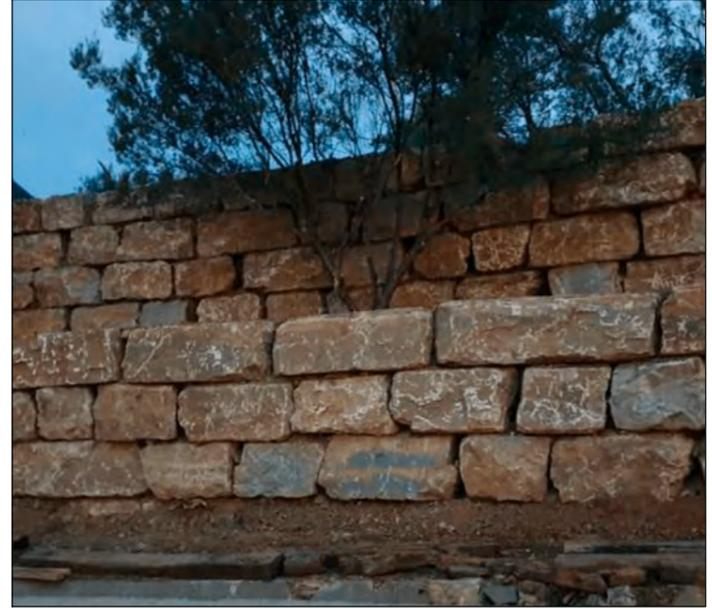
EJEMPLO DE MURO DE ESCOLLERA COLOCADA
