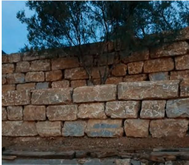
La superficie de apoyo de la primera hilada de escollera sobre la cara superior del cimiento de escollera hormigonada debe tener una inclinación media hacia el trasdós en torno al 3H:1V y presentar una superficie final dentada e irregular, que garantice la trabazón entre el cuerpo del muro y la cimentación.
