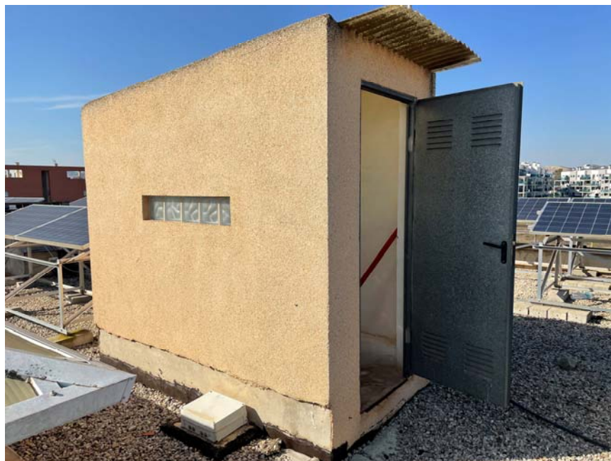
ZONA DE ACCESO A LA CUBIERTA
