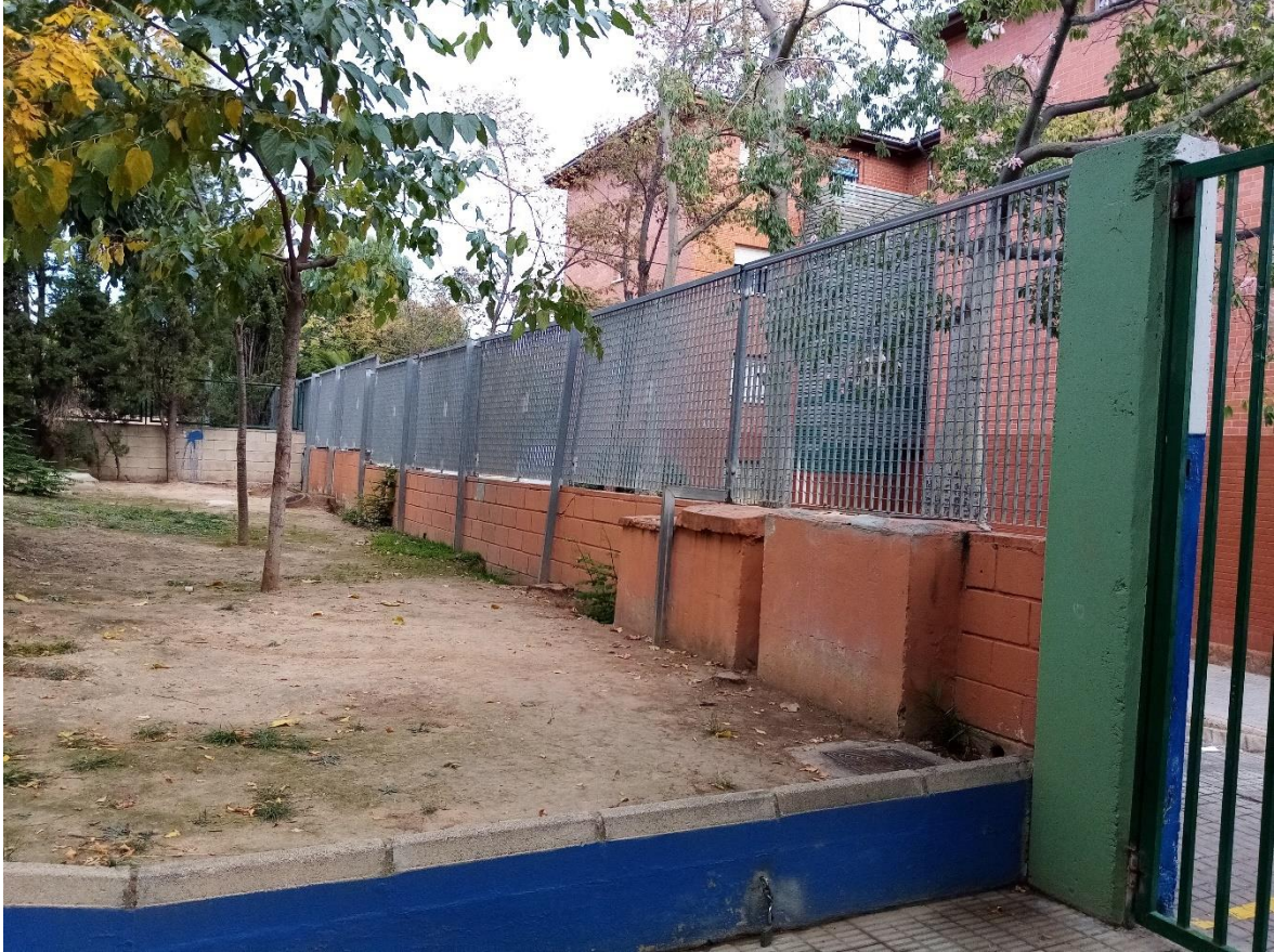
Tramo de muro a reconstruir.
