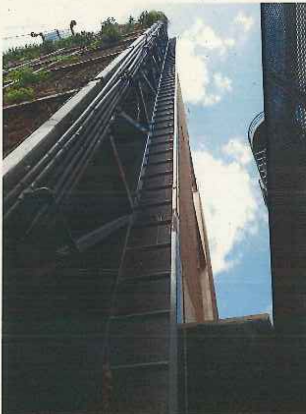
Foto 5- Escalera auxiliar lateral de jardín vertical junto acceso a Auditorio
