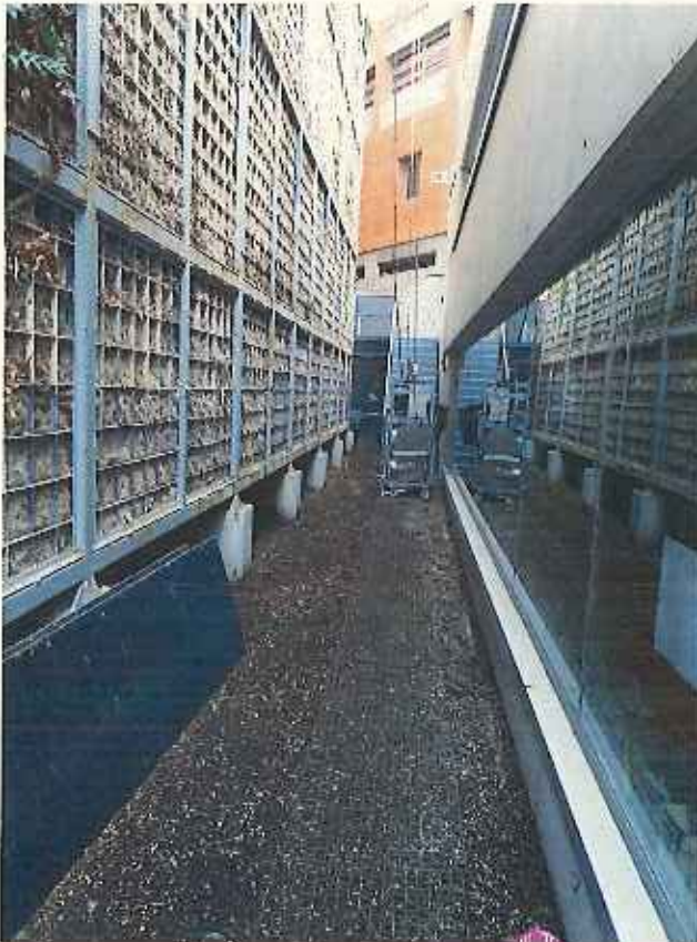
Foto 4- Vista general pasillo evacuación/ espacio de trabajo
