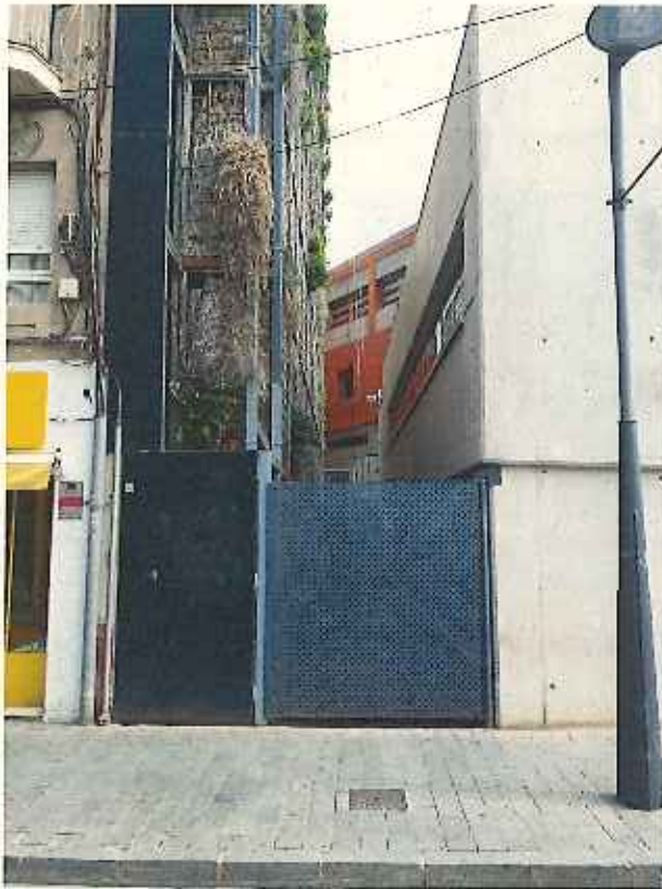
Foto 3- Vista general puerta y cancela de acceso al Jardín vertical
