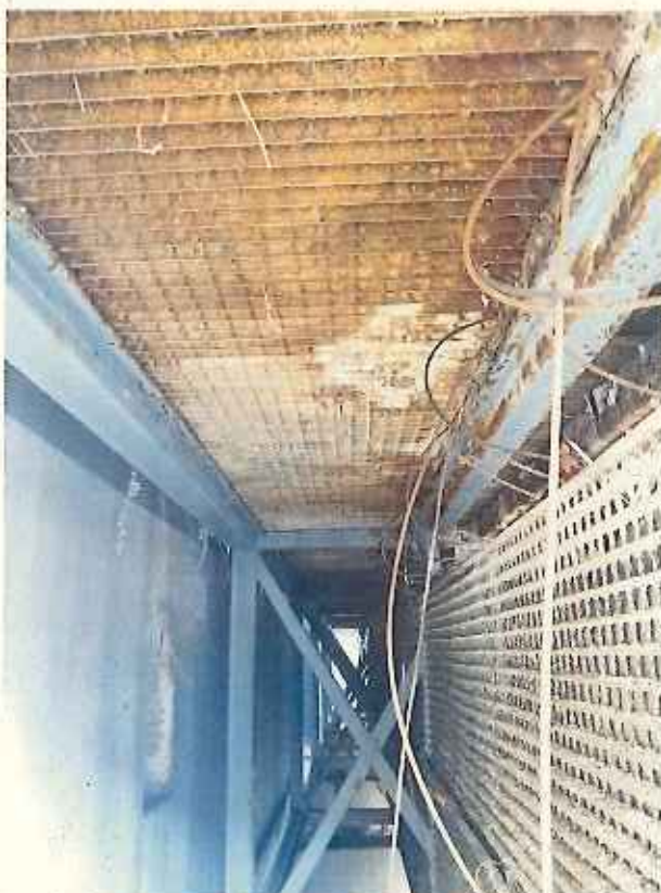
Foto 7 - Vista general interior estructura sustentadora jardín
