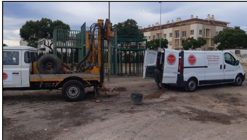
Fotografía 2.- Emplazamiento del SRV-2.
