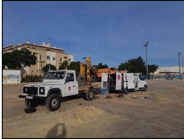
Fotografía 1.- Emplazamiento del SRV-1.
