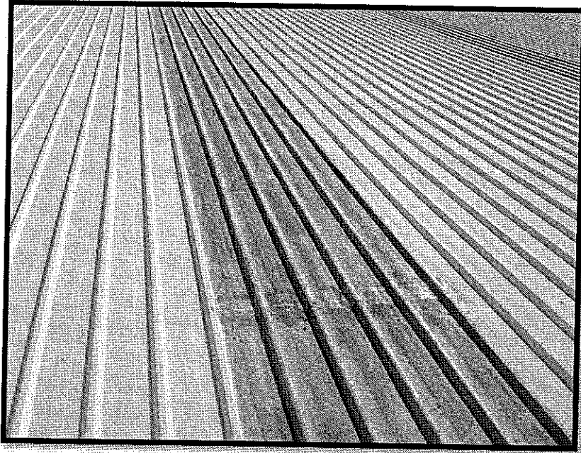
VISTA GENERAL DE LA CUBIERTA INCLINADA
