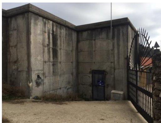
Vista exterior de la estación de bombeo
