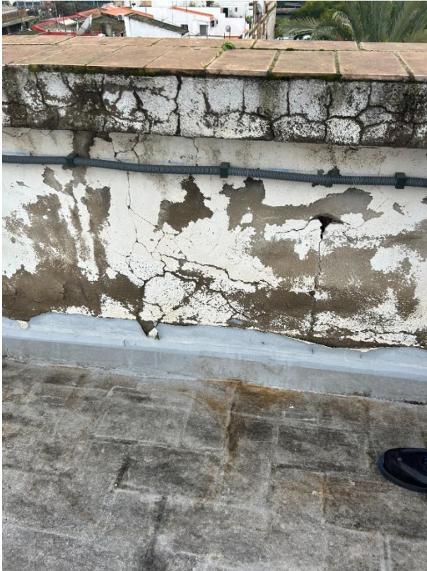
Detalles del estado de pretil y cumbrera entre paños de cubierta
