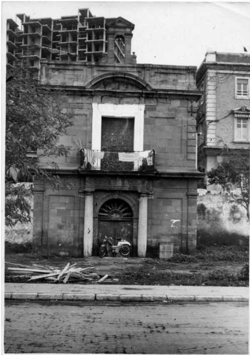
Estado de abandono previo al traslado.
