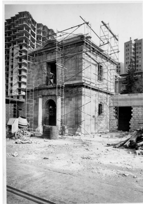
Reconstrucción en su actual posición. Se empotró la parte trasera bajo el paseo de la farola.
