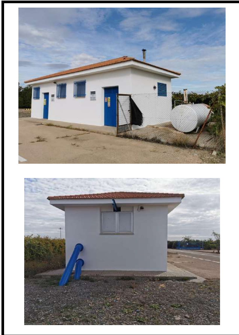
Imagen 2: Edificio grupo de presión
