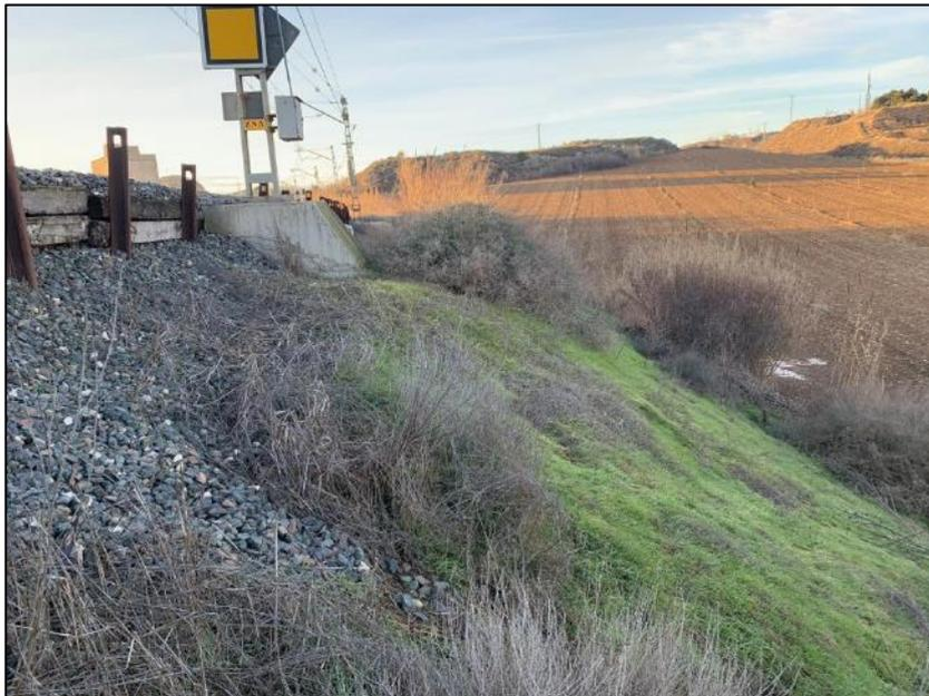
Fig 10. Derrames de balasto y deformación del terraplén.
