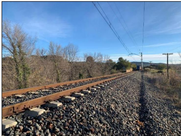
Fig 31. Derrames de balasto.
