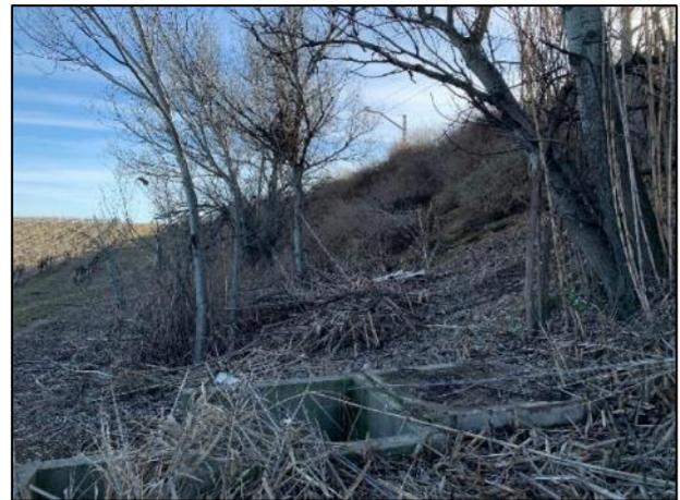
Fig 17. Estado del drenaje transversal tras el paso de Filomena
