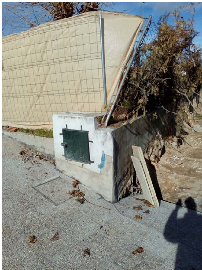
1.- Emplazamiento muro contención.
