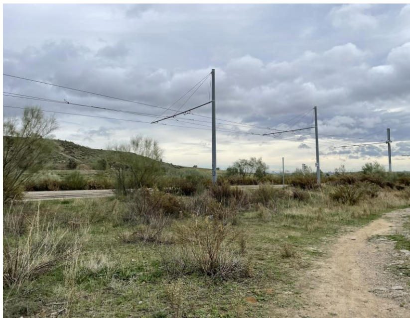
Figura 8 Situación actual tramo Norte
