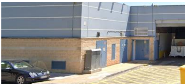
Figura 19. Ubicación centro de mando existente
