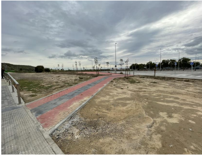
Figura 7 Conexión ya ejecutada del vial peatonal con el parking disuasorio Sur
