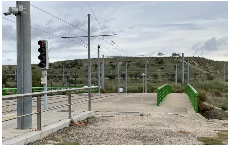
Figura 9 Vista de los dos tableros existentes en el cruce con la M408
