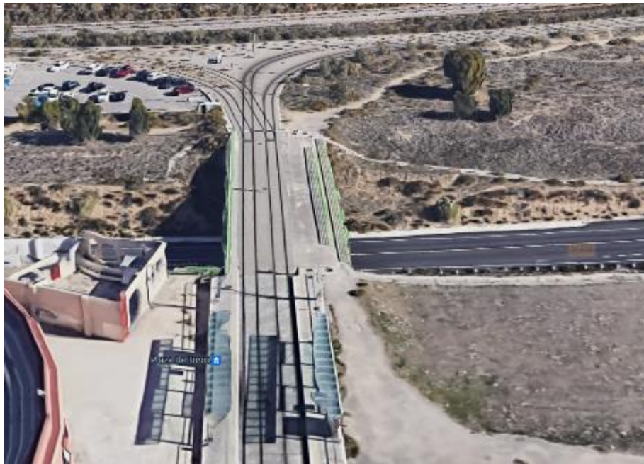
Figura 16. Paso superior sobre carretera M408
