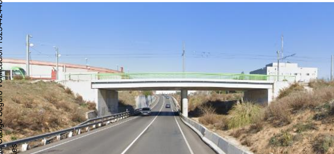
Figura 10. Estado actual puente de paso sobre la carretera M408
