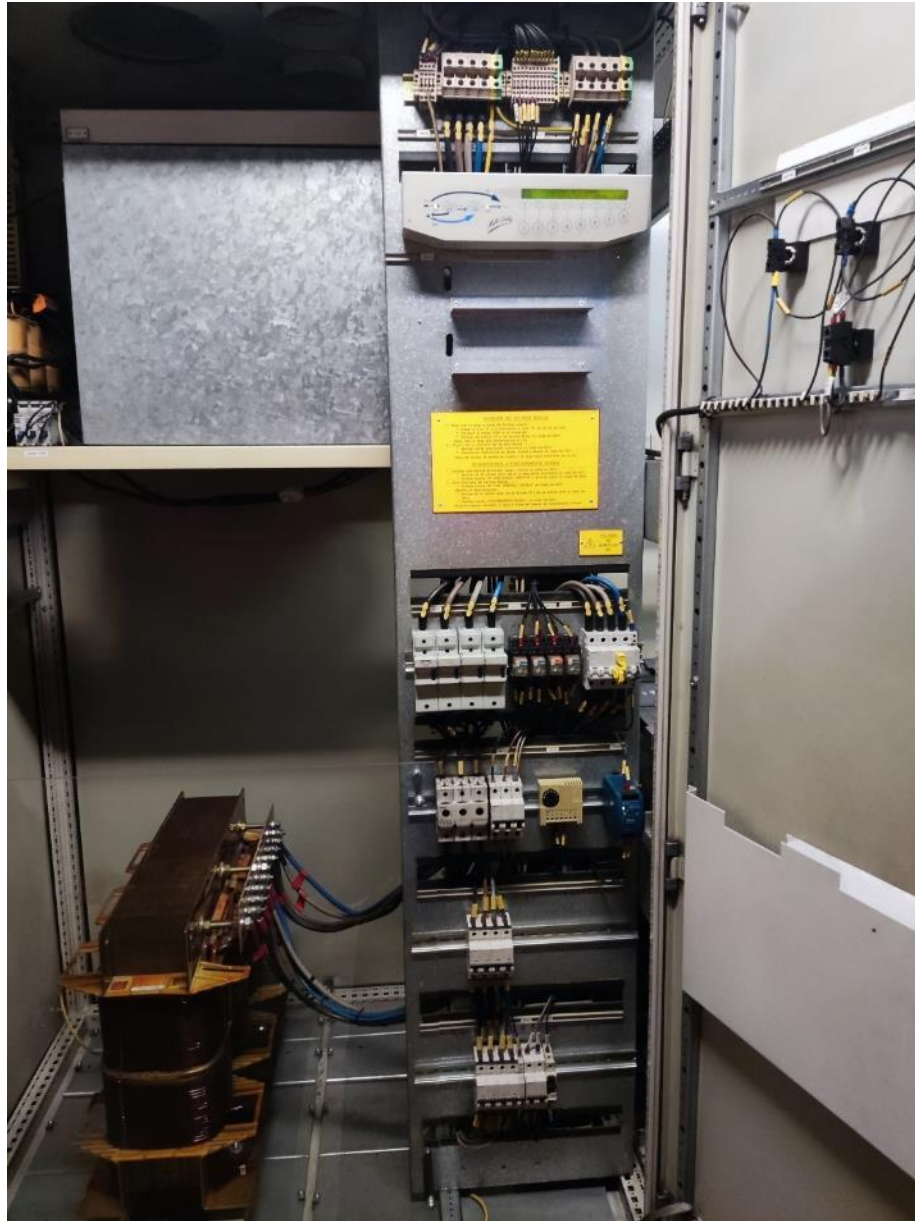
Ilustración 21: Electrónica de las SAIs actuales
