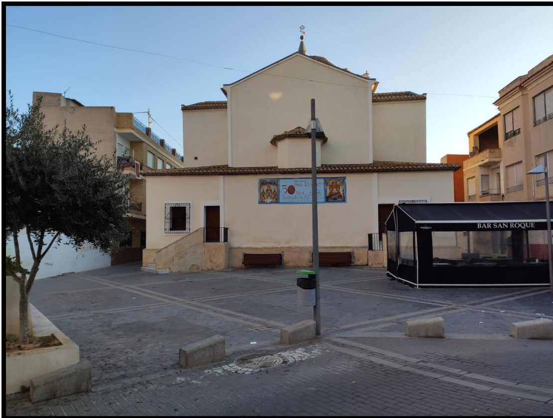
Fachada Oeste (C/ del Aire)
