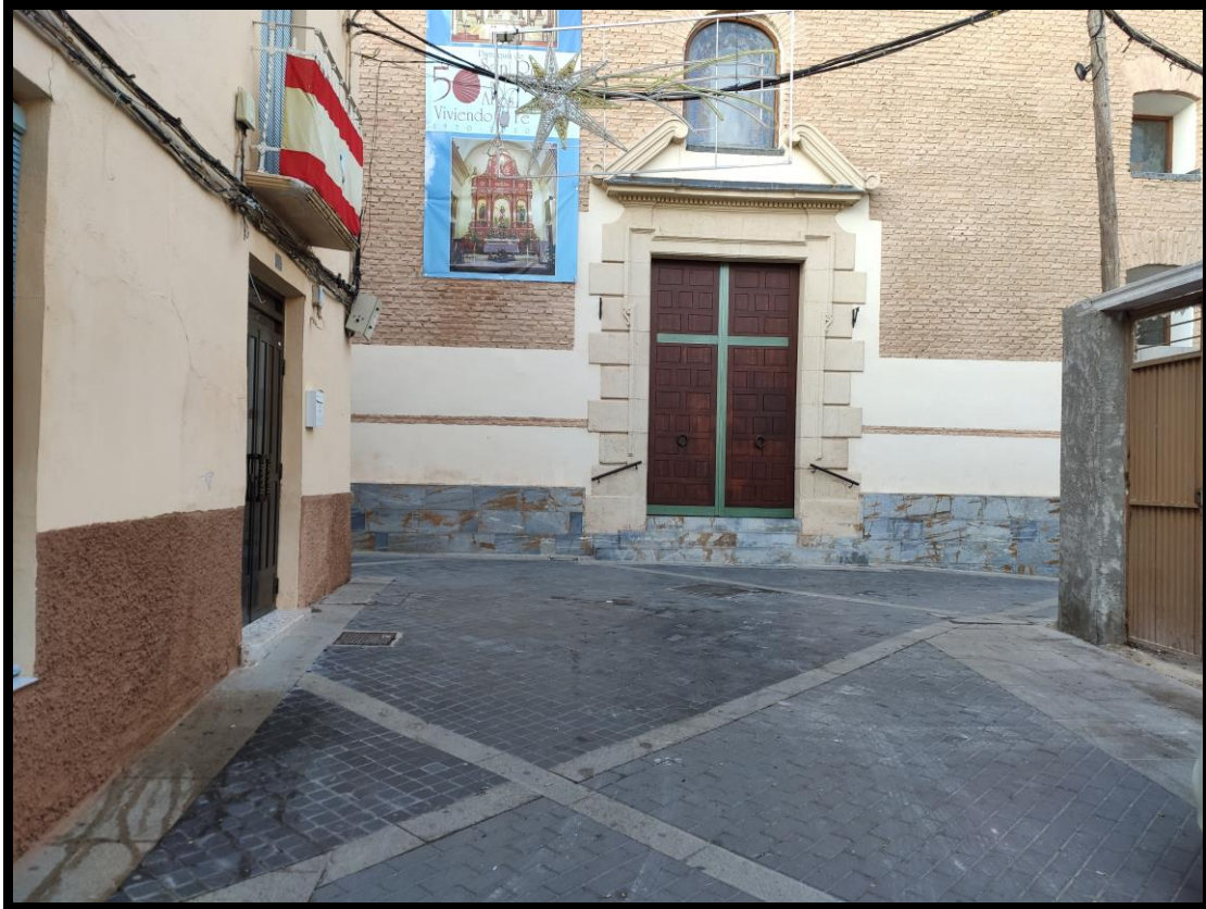
Fachada Este (C/ San Roque)
