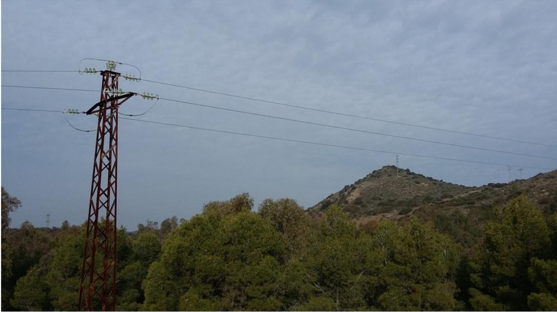
**Poste final de línea de alta tensión que se sustituirá y realizará la bajada con cable.**
