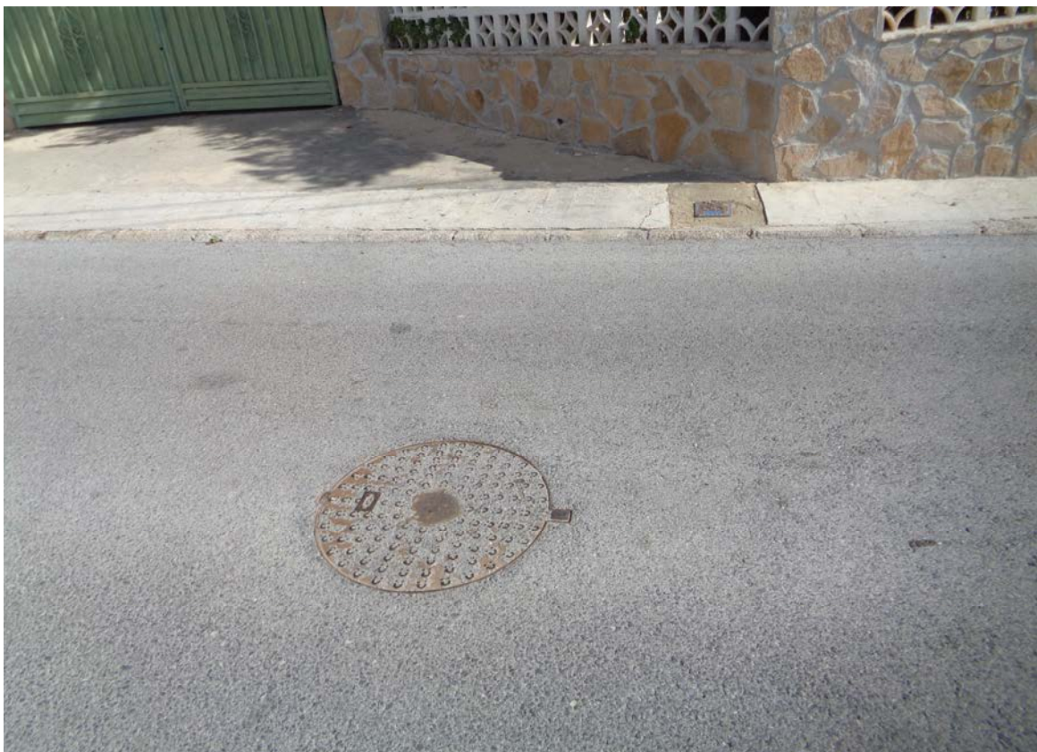
FOTOGRAFÍA 8: Vista de saneamiento de la calle Cisne.
