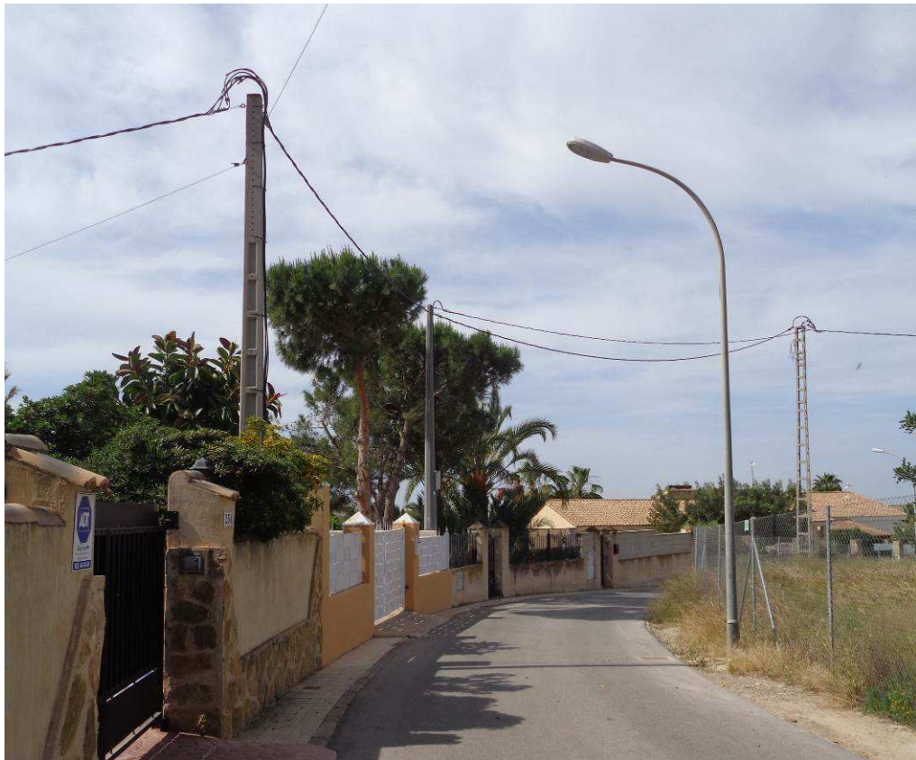
FOTOGRAFÍA 5: Vista de postes de instalación eléctrica y de alumbrado junto a solar.
