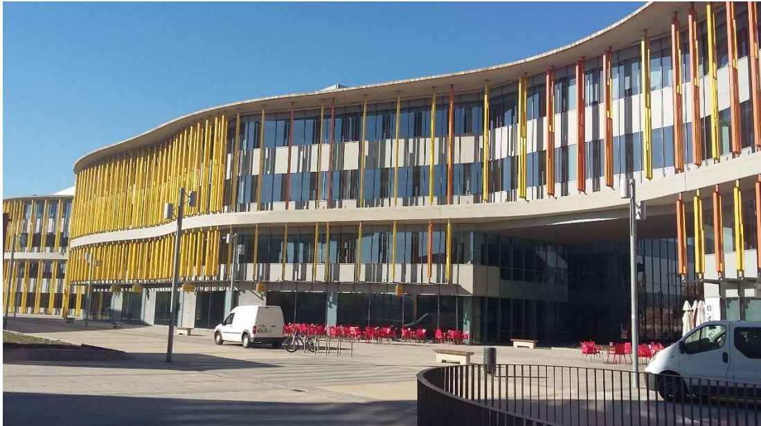
Fotografía 1.- Imagen general del edificio
