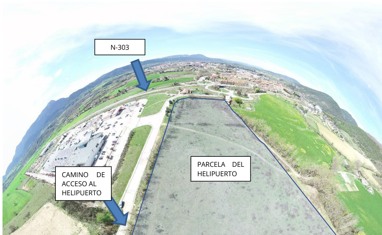
Figura 11. Acceso al helipuerto
