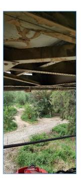
En proyecto estaba previsto la sustitución de muchos de ellos, con la filosofía de priorizar la conservación de elementos originales del puente siempre que la magnitud de los daños lo haga posible, se plantea la reparación de los mismos, mediante chorreo de sílice superior e inferior de casetones, sellado de perforaciones, imprimación y regularización horizontal con hormigón de limpieza HM-20.
