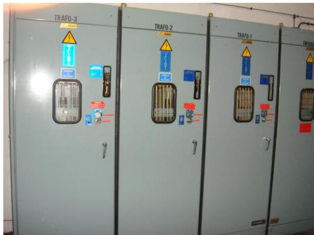
Foto1 Celdas de línea de entrada y de protección de trafo.
