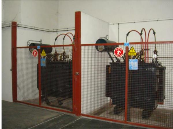
Foto 2 Trafos 1 y 2, existentes a sustituir el trafo 2 y eliminar el trafo 1
