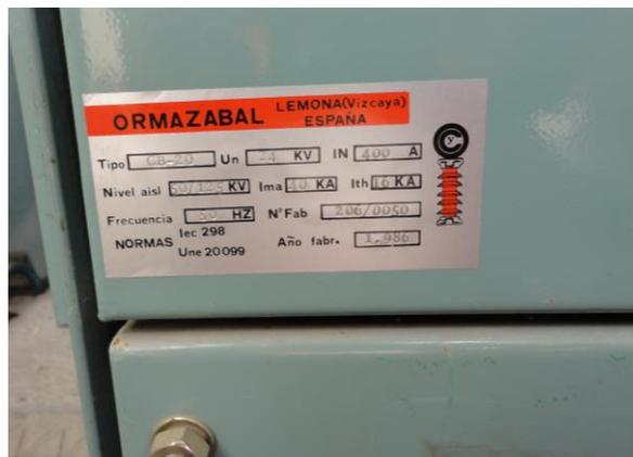
Foto 9 Placa de características de celdas de centro de seccionamiento
