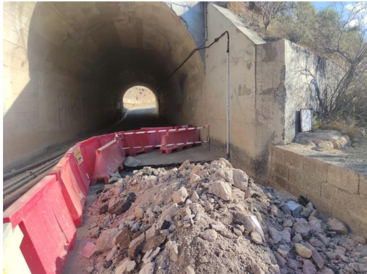
*Por todo ello los trabajos entre los PP.KK. 2+060 y el 2+100 y coincidentes con el paso inferior donde se debe ejecutar la ODT no se pueden ejecutar hasta que no se desvien los servicios afectados encontrados.*
