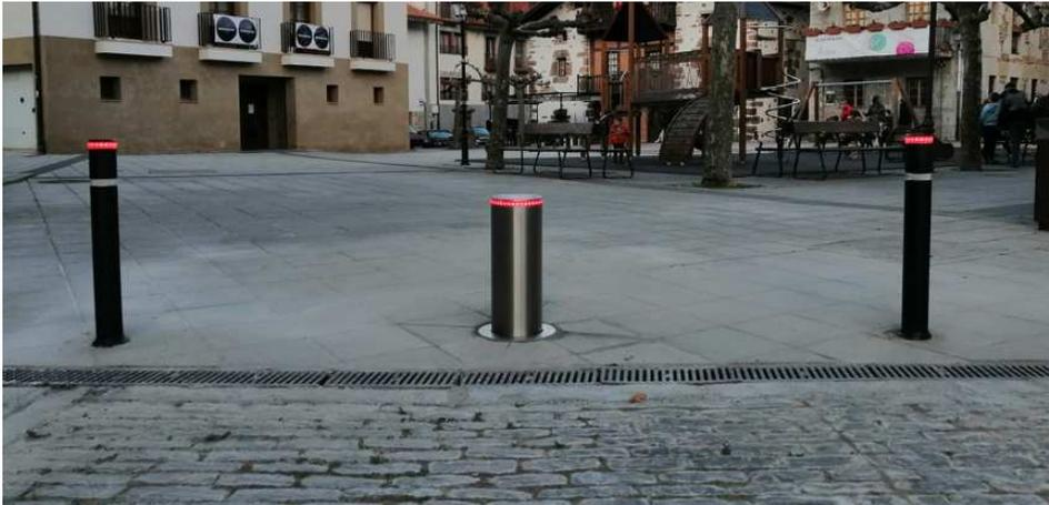
Se suministrarán e instalarán dos Pilonas (BOLARDOS) con corona luminosa con LED, de altura 1m y diámetro 100mm, fabricada en poliuretano flexible en color negro resistente a los rayos UV, con una banda reflectante, con bases de poliuretano o de acero inoxidable o en versión
