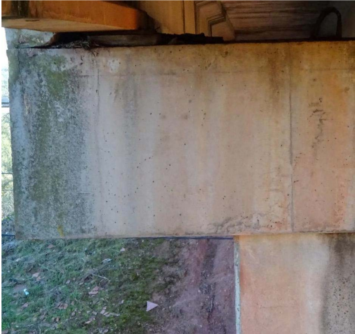
Imagen 14. Detalle del tablero haciendo tope con el parapeto del dintel, en la parte superior izquierda de esta foto.
