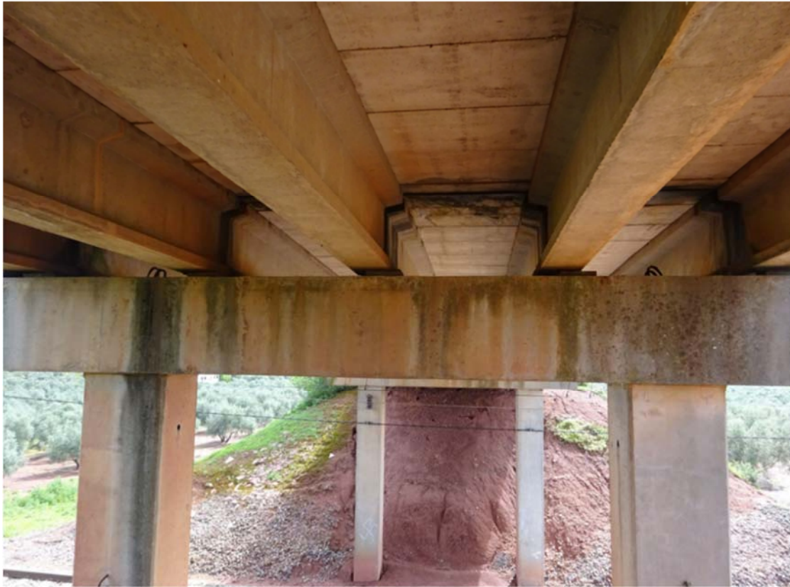
Imagen 12. Vista general del dintel entre vano ferroviario y vano derecho.
