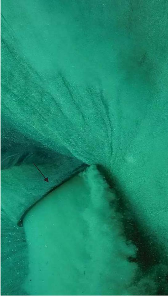
El cráter tiene unos tres metros de diámetro aproximadamente. En el fondo del mismo se observa el borde superior de la conducción y la salida de efluente, que evita que se derrumbe el talud frontal de arena de la salida.
