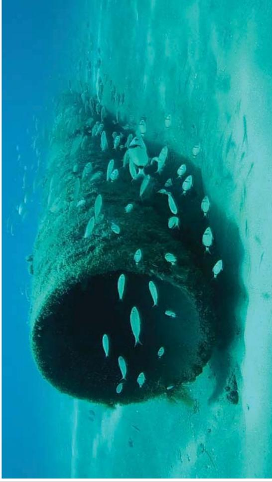
El extremo del emisario se encuentra abierto y sin obstrucción aparente a 8,3 m. de profundidad. En su interior hay un fino lecho de arena en la parte basal.
