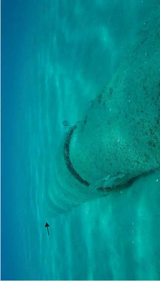
A unos escasos nueve metros del final la conducción el emisario queda soterrado. La imagen muestra la unión entre tubos y el punto de soterramiento
