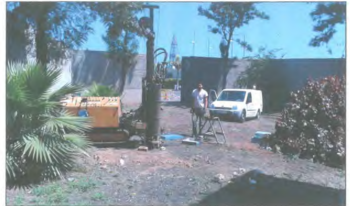
Emplazamiento del sondeo S-3
