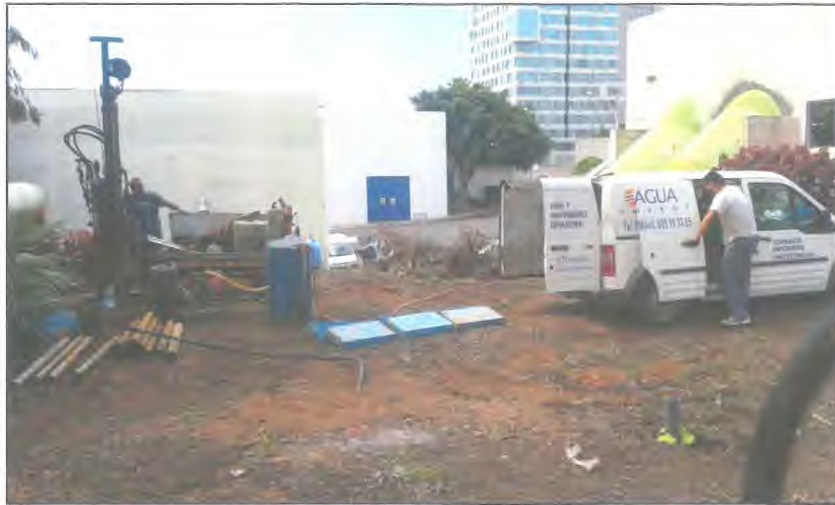
Emplazamiento del sondeo S-2
