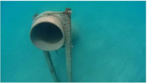
Para realizar la revisión se detiene el sistema de bombeo con el fin de poder comprobar que el efluente llega hasta el final de la conducción. La fotografía no muestra salida de efluente.
