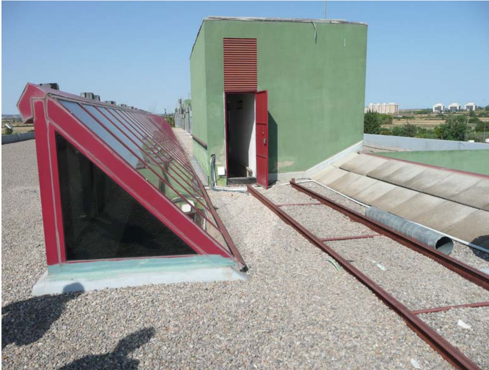
Zona de la cubierta superior a impermeabilizar. Se observa el torreón del ascensor, los raíles de la góndola limpiacristales y el lucernario.
