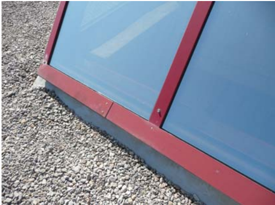
Tapajuntas inferior de la zona inclinada
