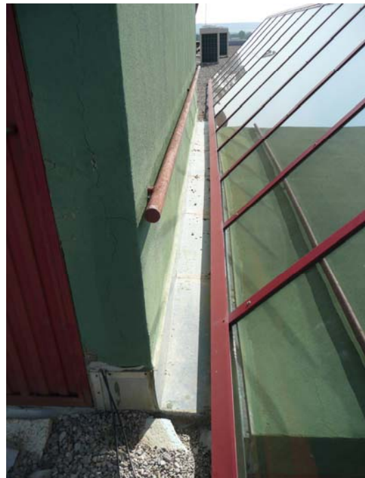
Canal a sustituir
