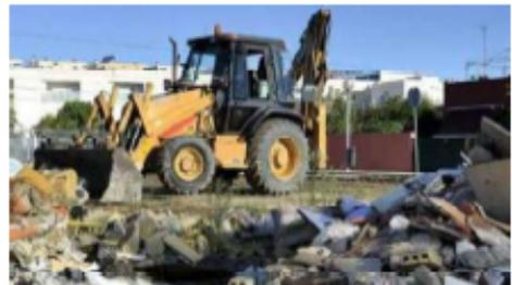
Con ayuda de la retro se realizará la fragmentación de los escombros, en piezas manejables para ser cargadas sobre camión en caso necesario a continuación bien se cargaran directamente sobre camión o acopiarán hasta su retirada y traslado a vertedero en montones con una altura que no supere los 2 m.
