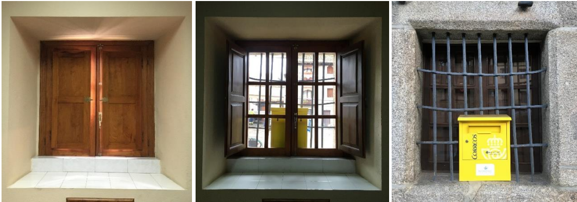
Foto 2. Planta baja. Sala de Correos.
